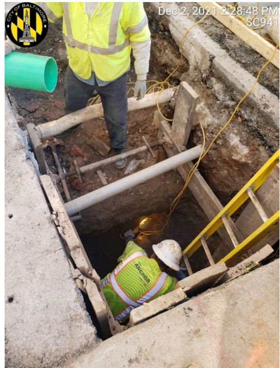
Sewer Rehab (W Mt Royal Ave)
