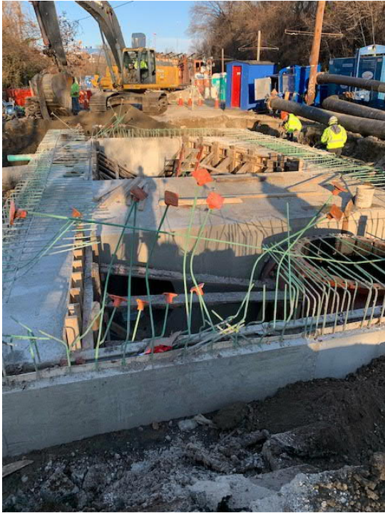
Confluence Structure A (Falls Rd)
