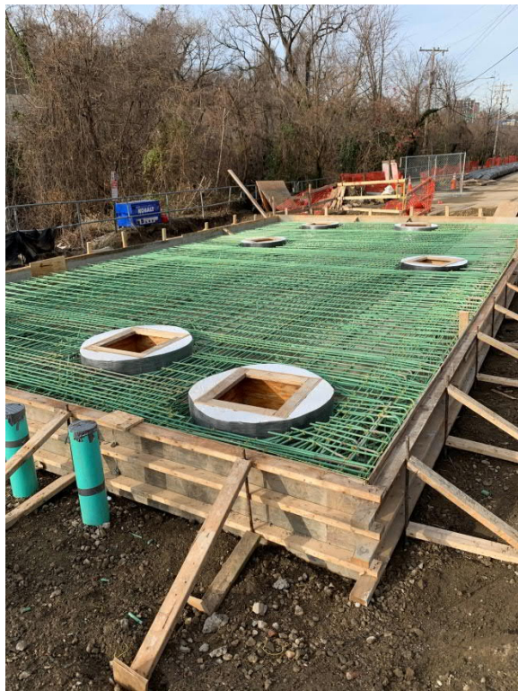
Top Slab of Structure A ready for pour
