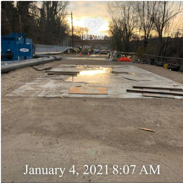
Confluence Structure A (Falls Rd)
