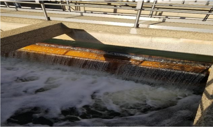
Fig. 2: Patapsco WWTP final effluent
